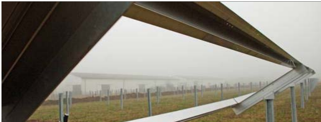
Für die neue Photovoltaikanlage im Gewerbegebiet Wandersleben wird derzeit die Unterkonstruktion errichtet. Foto: Claudia Klinger
